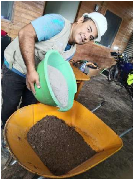
Fotografía 5. Mezclado de agregado grueso, agregado fino y cenizas en reemplazo al cemento al 0%, 5%, 10% y 15% por el Bachiller Dick Rolling Castillo Vasquez.
