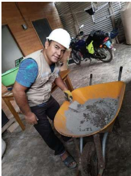
Fotografía 6. Mezcla de dosificación obtenida según diseño de mezcla para elaboración de adoquines F' c = 210 \text{ kg/cm}^2 , Bachiller Dick Rolling Castillo Vasquez.
