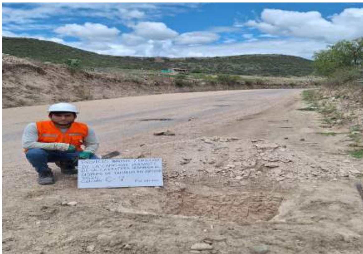
CALICATA N.º 7: Excavación y extracción de muestras de calicatas, profundidad 1.50 mts.
