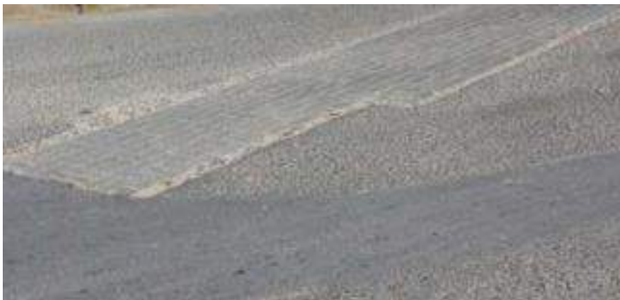
Figura 9. Parcheo y Acometidas de Servicios Públicos
