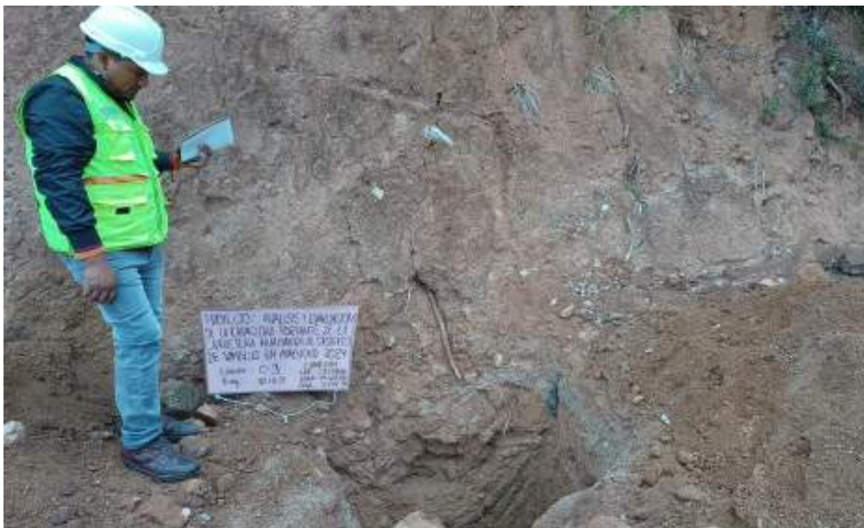
CALICATA N.º 3: Excavación y extracción de muestras de calicatas, profundidad 1.50 mts.
