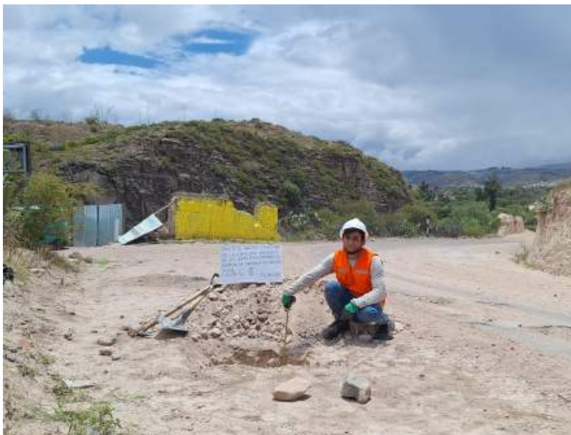
ALICATA N.º 8: Excavación y extracción de muestras de calicatas, profundidad 1.50 mts.
