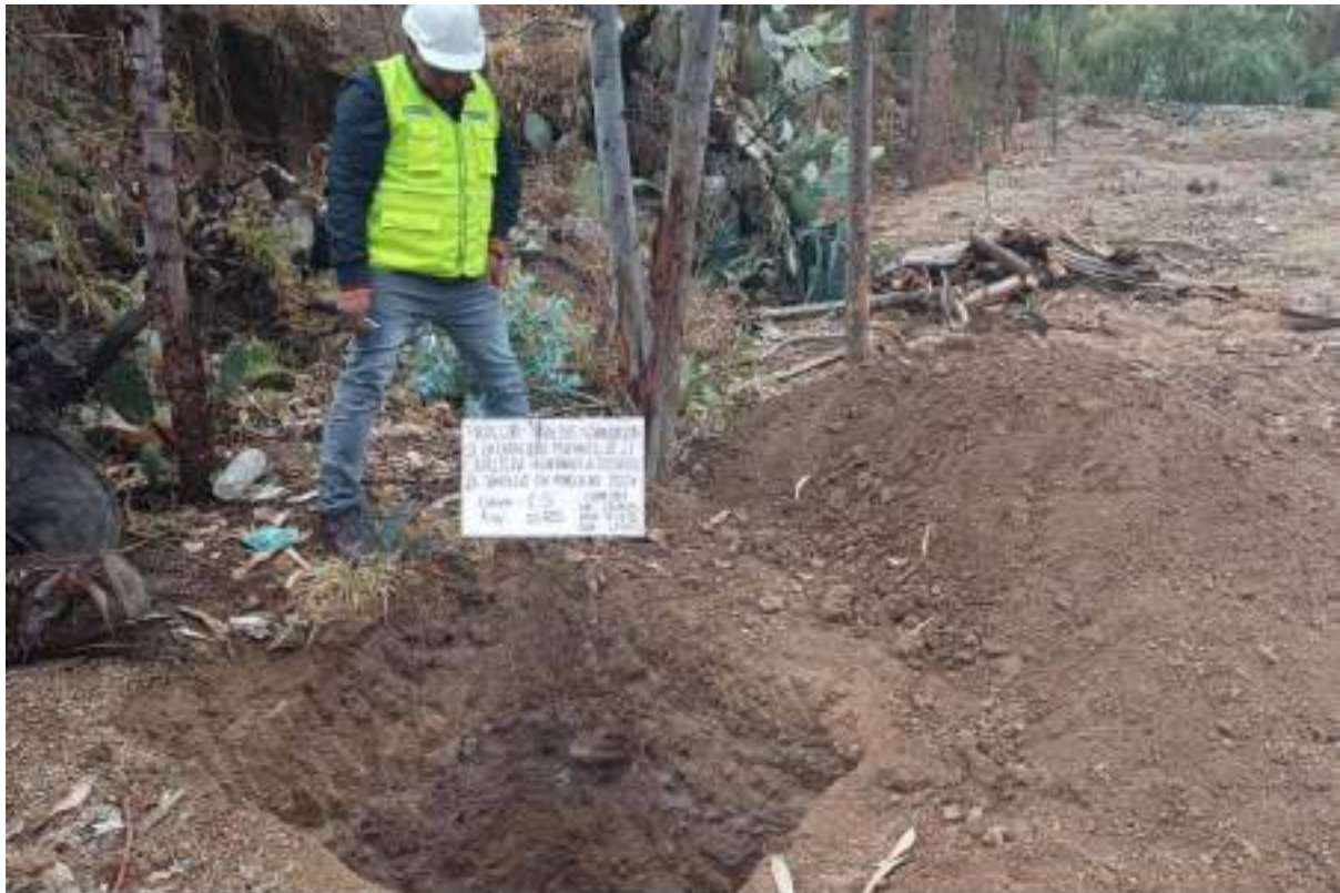
CALICATA N.º 5: Excavación y extracción de muestras de calicatas, profundidad 1.50 mts
