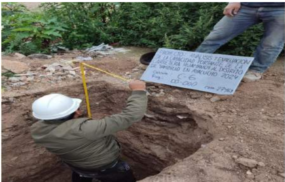
CALICATA N.º 6: Excavación y extracción de muestras de calicatas, profundidad 1.50 mts
