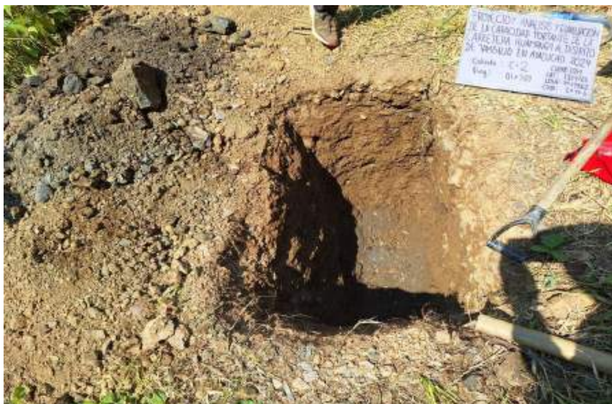
CALICATA N.º 2: Excavación y extracción de muestras de calicatas, profundidad 1.50 mts
