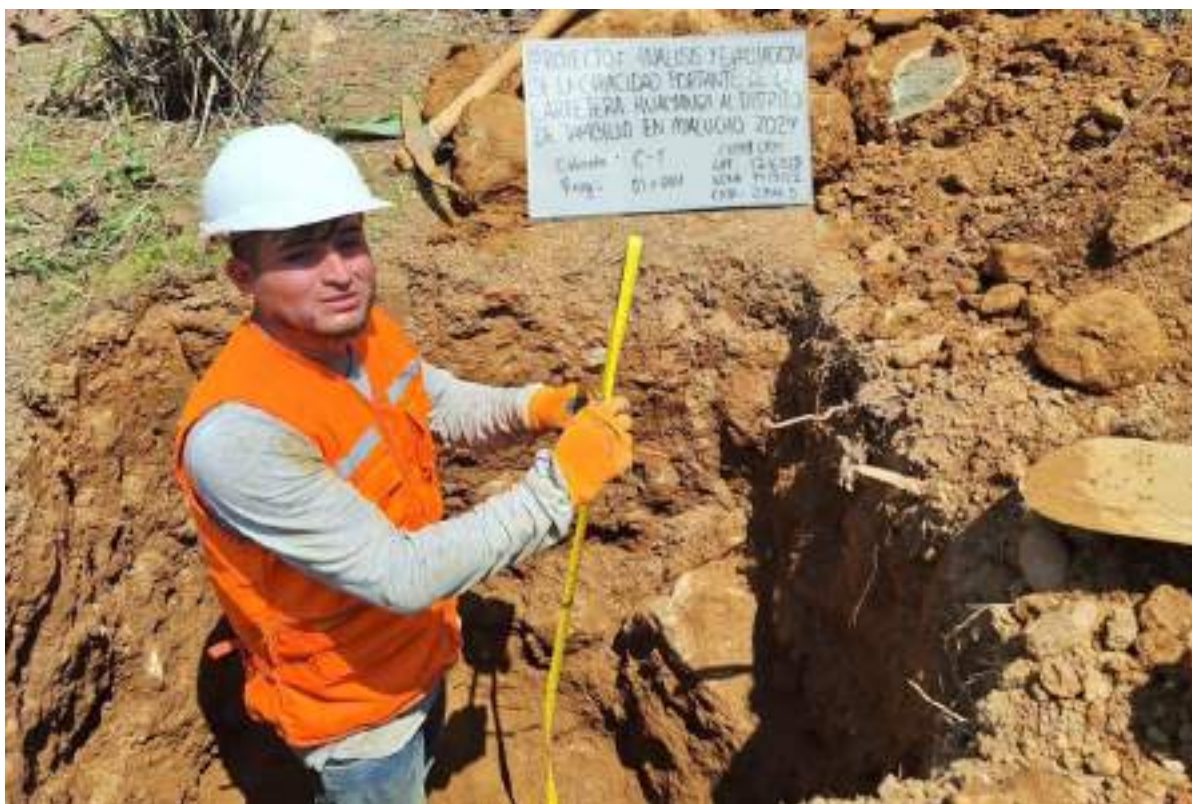
CALICATA N.º 1: Excavación y extracción de muestras de calicatas, profundidad 1.50 mts
