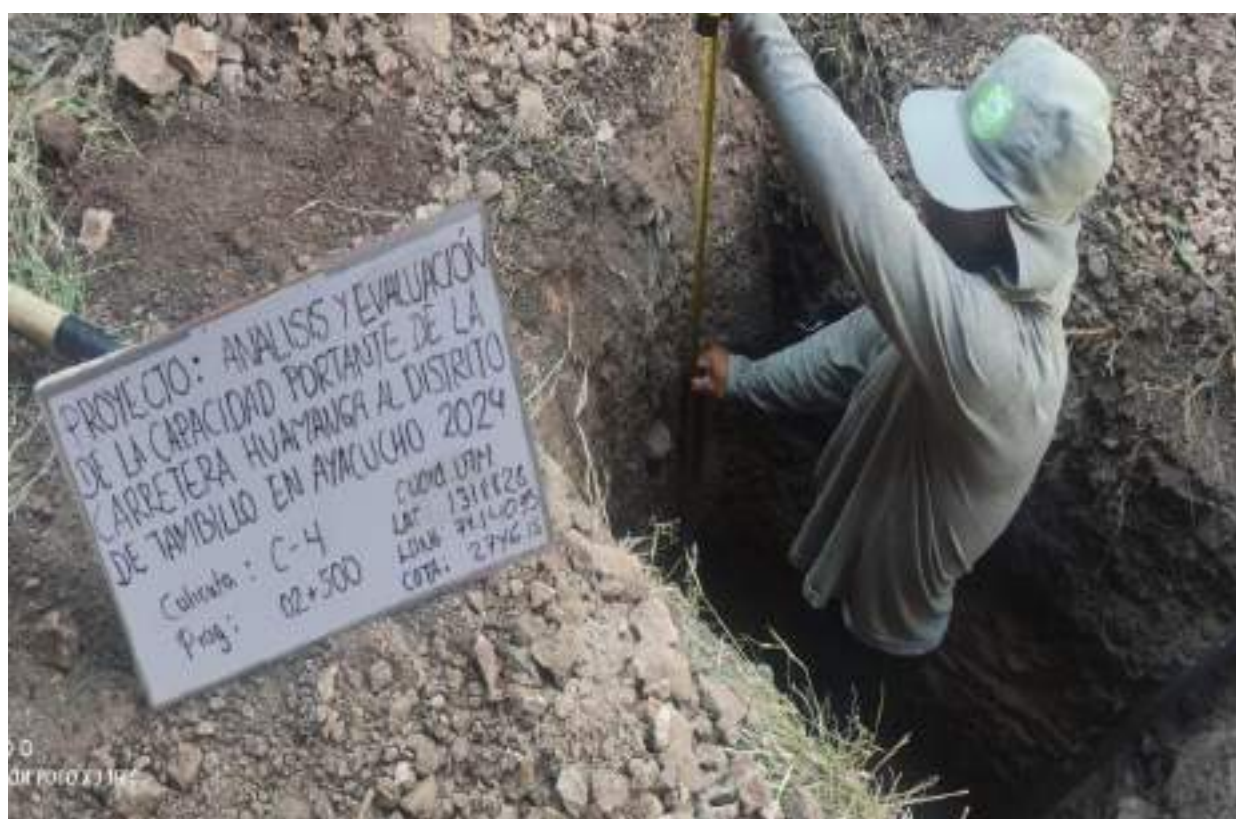
CALICATA N.º 4: Excavación y extracción de muestras de calicatas, profundidad 1.50 mts
