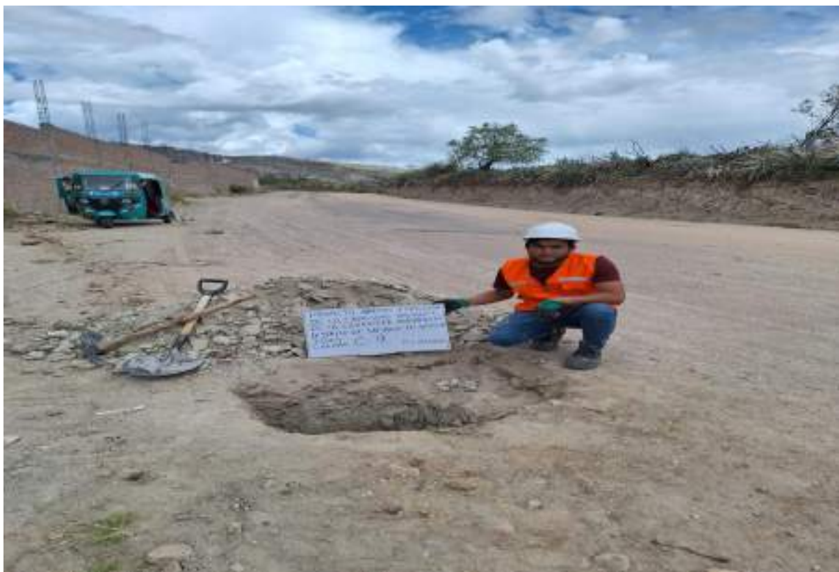
CALICATA N.º 9: Excavación y extracción de muestras de calicatas, profundidad 1.50 mts
